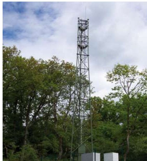
Pylône à Alligny-en-Morvan
