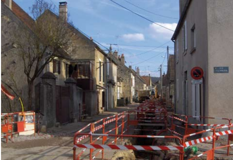
Travaux mixtes : électricité, gaz, éclairage publique à Dornecy
