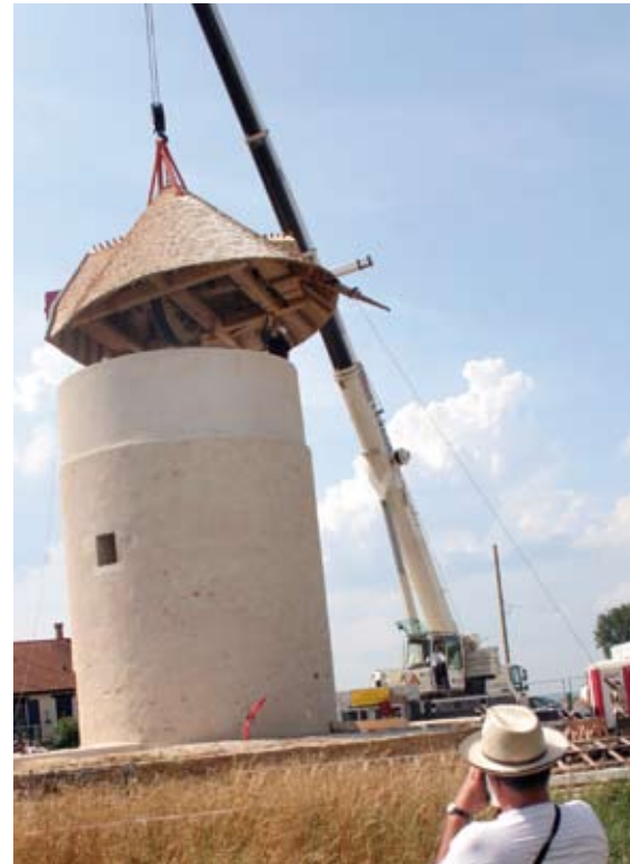
Pose de la toiture sur le Moulin des Événés
