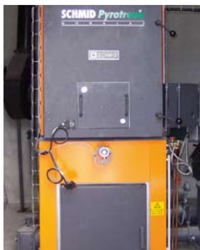
Chaudière à Arquian
