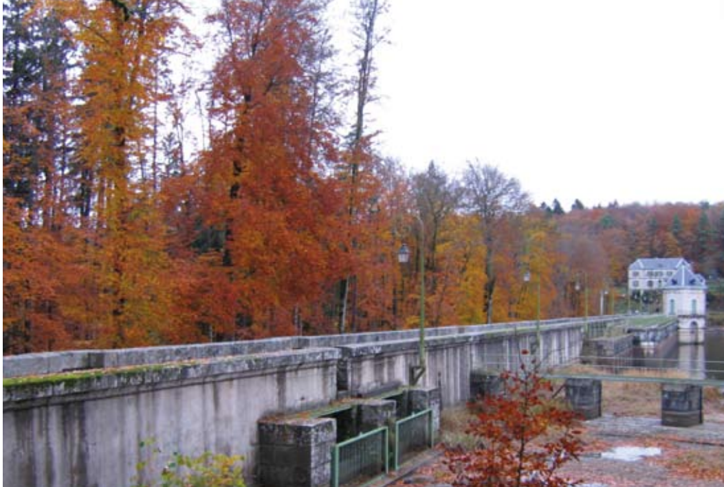
Barrage central des Settons
