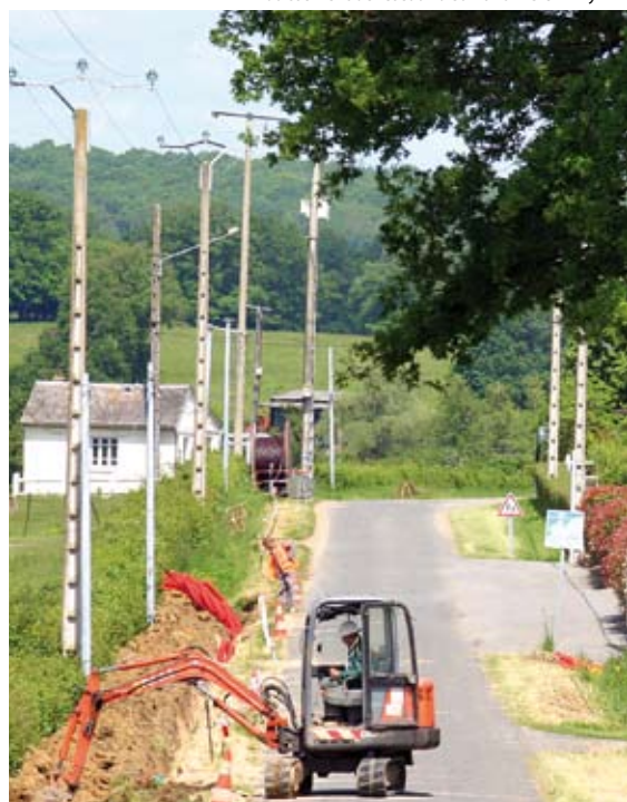
Enfouissement de réseaux à Saint-Parize-en-Viry
