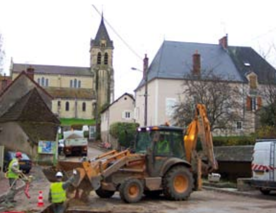
Enfouissement de réseaux à Chaulgnes
