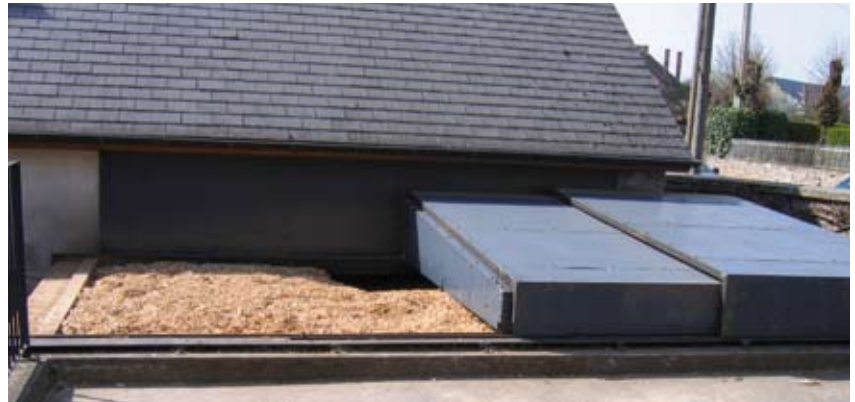
Silo chaufferie à Millay
