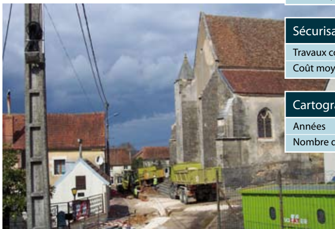
Enfouissement de réseaux à Bitry
