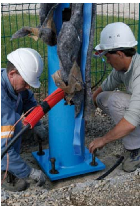
Pose de mât d'éclairage sportif
