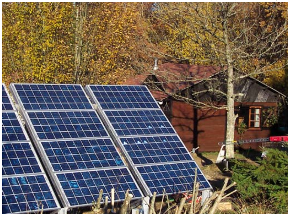
Desserte photovoltaïque site isolé à Chasnay
