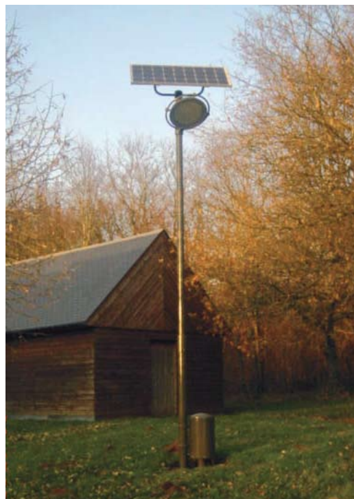
Éclairage photovoltaïque du village vacances de Saint-Agnan
