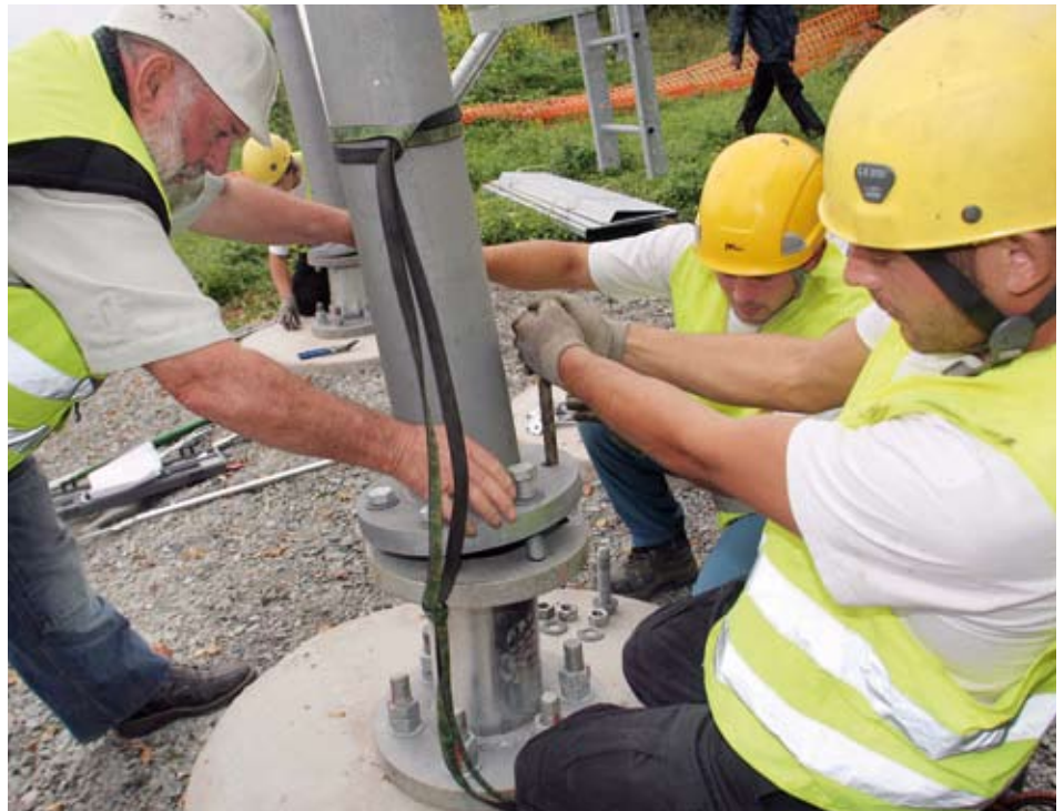
Montage pylône à Saint-Firmin
