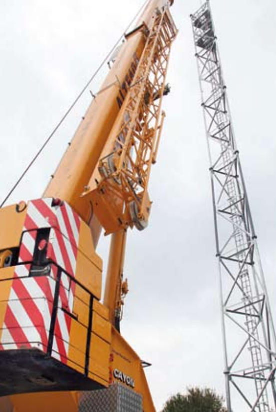
Levage Pylône à Saint-Firmin
